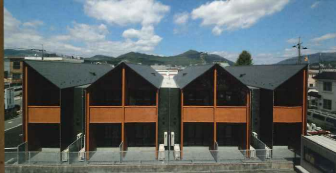
周囲に連なる山々の屋根との調和を図った屋根形状。
